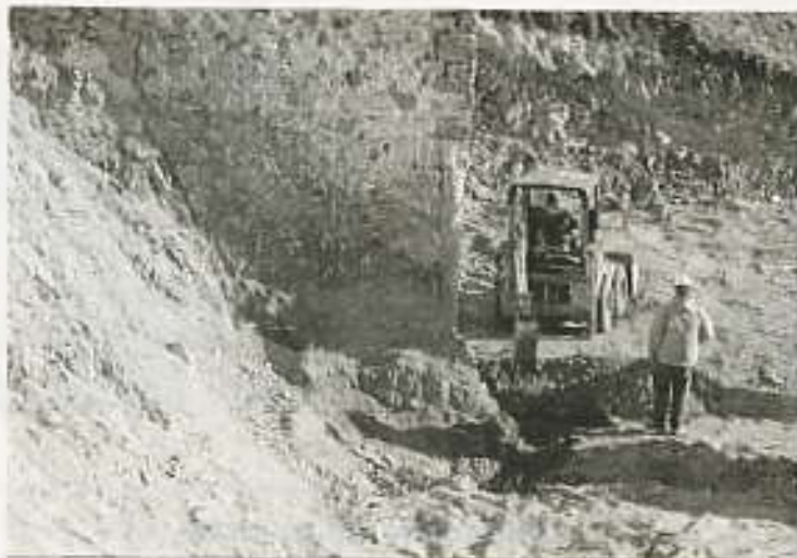
Trabajos en la base de la Torre del Miramar de Tarifa.
